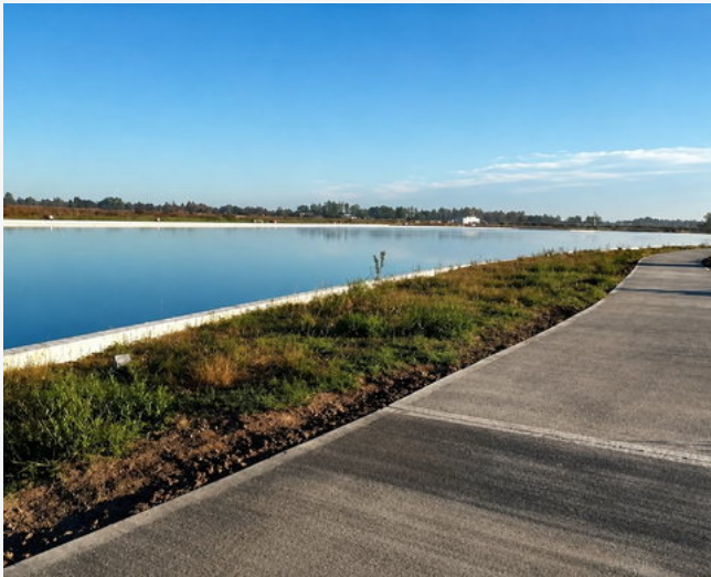
VEREDA TERMINADA JUNTO A LA LAGUNA
