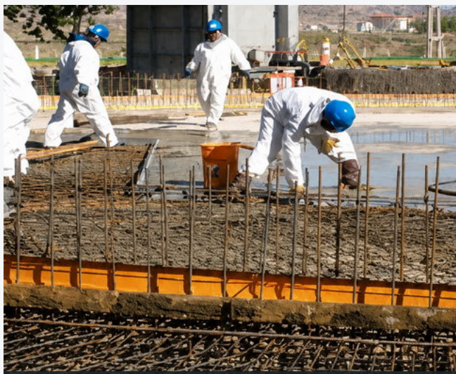
HORMIGONADO Y ARMADURAS
