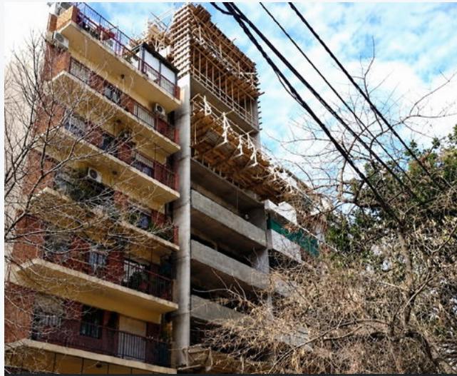
AVANCE EXTERIOR DE LA ESTRUCTURA
