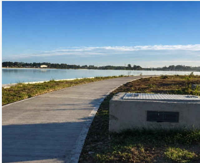
VEREDA Y CÁMARA TERMINADAS
