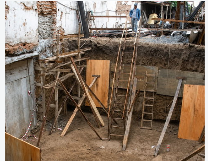
EXCAVACIÓN Y APUNTALAMIENTO
