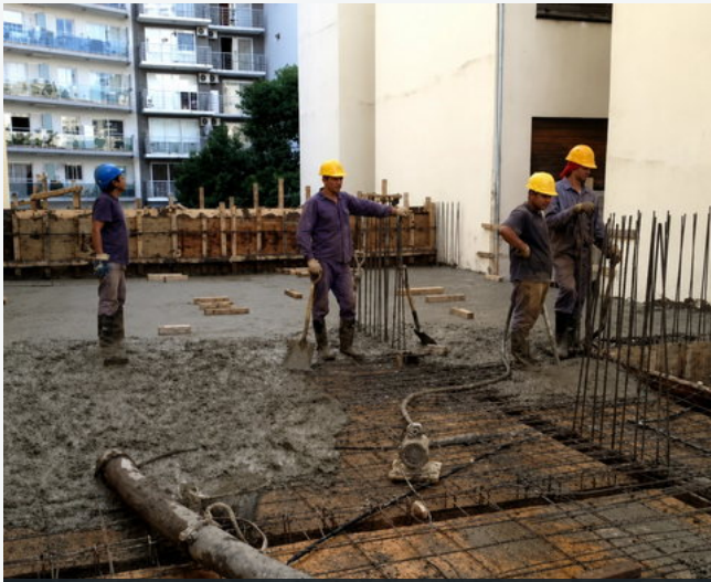
HORMIGONADO DE LOSA
