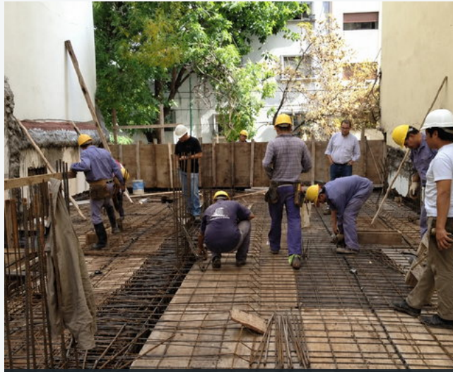
ARMADO DE LOSA
