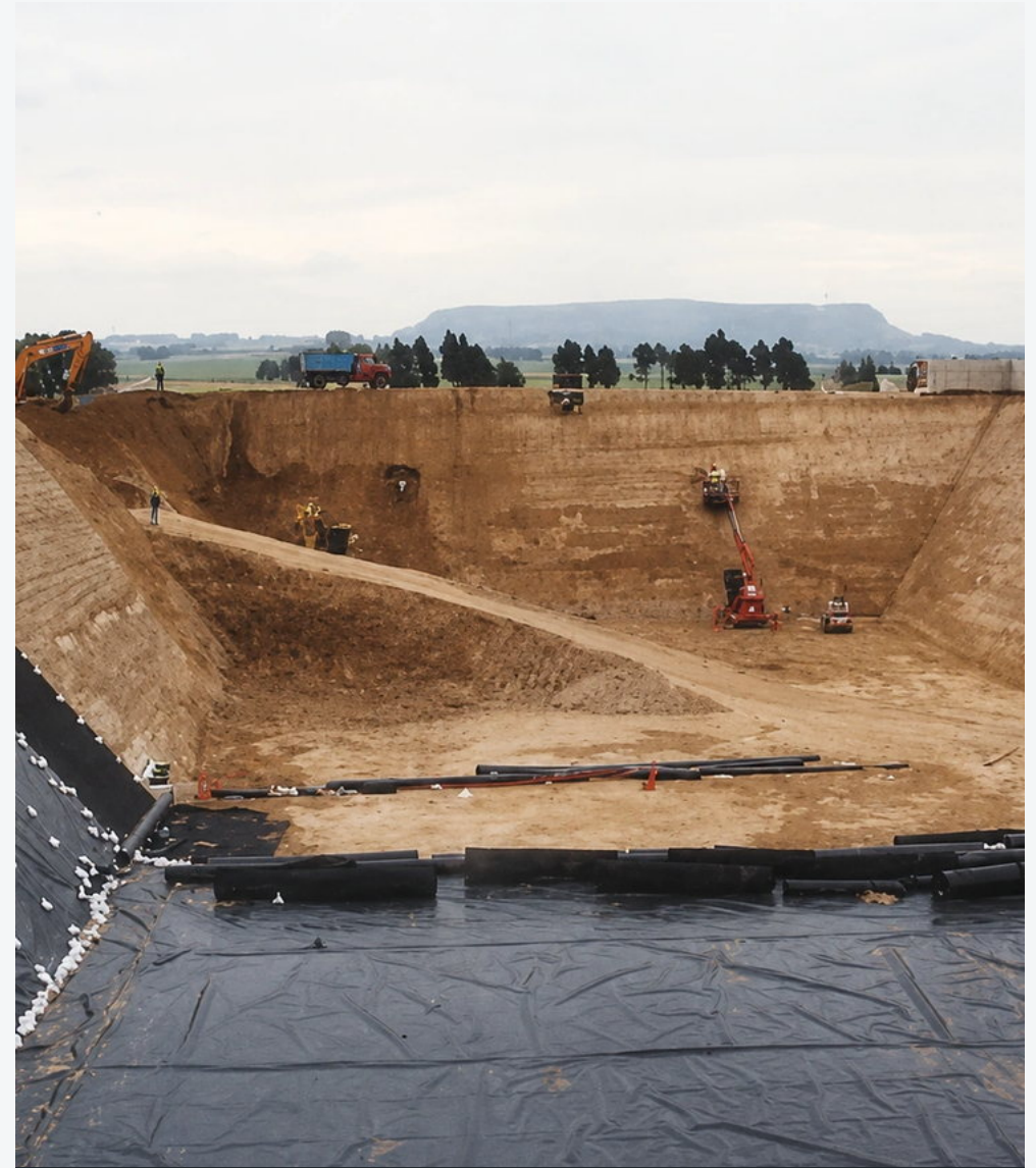
TALUDES Y REVESTIMIENTO CON MEMBRANA P.E.A.D.
