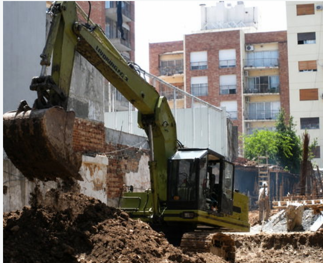
AVANCE DE EJECUCIÓN
