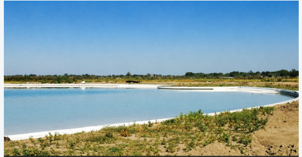
VISTA DEL ENTORNO DURANTE LA OBRA
