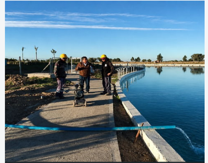
TRABAJO Y CONTROL DE TERMINACIONES
