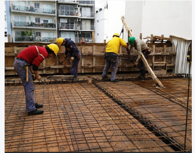
ENCOFRADO Y ARMADURAS DE LOSA
