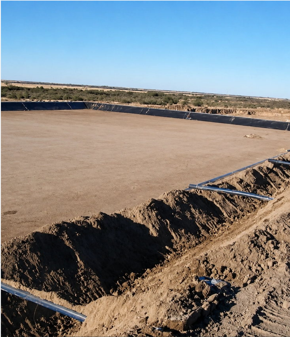
EXCAVACIÓN Y NIVELACIÓN DEL TERRENO
