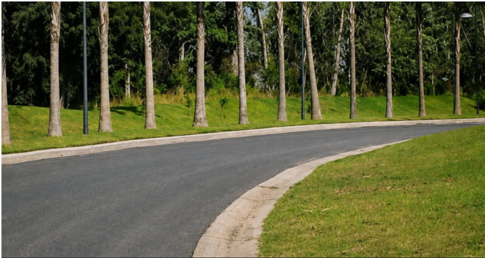
CALLE Y PAISAJE URBANO TERMINADOS
