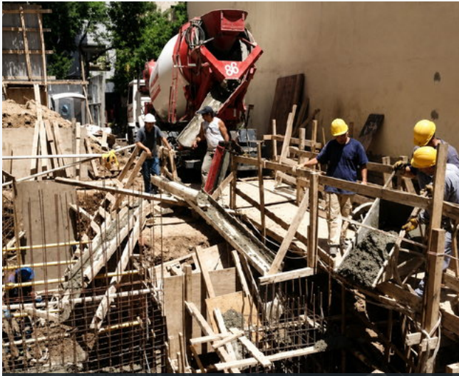
ESTRUCTURA Y ENCOFRADOS
