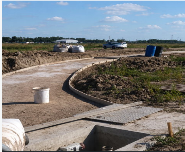
PREPARACIÓN DE BASES Y CÁMARAS
