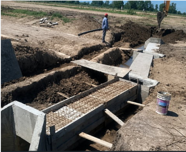
ESTRUCTURAS DE HORMIGÓN EN EJECUCIÓN
