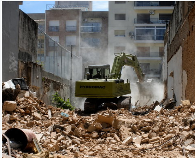
DEMOLICIÓN Y DESPEJE DEL TERRENO
