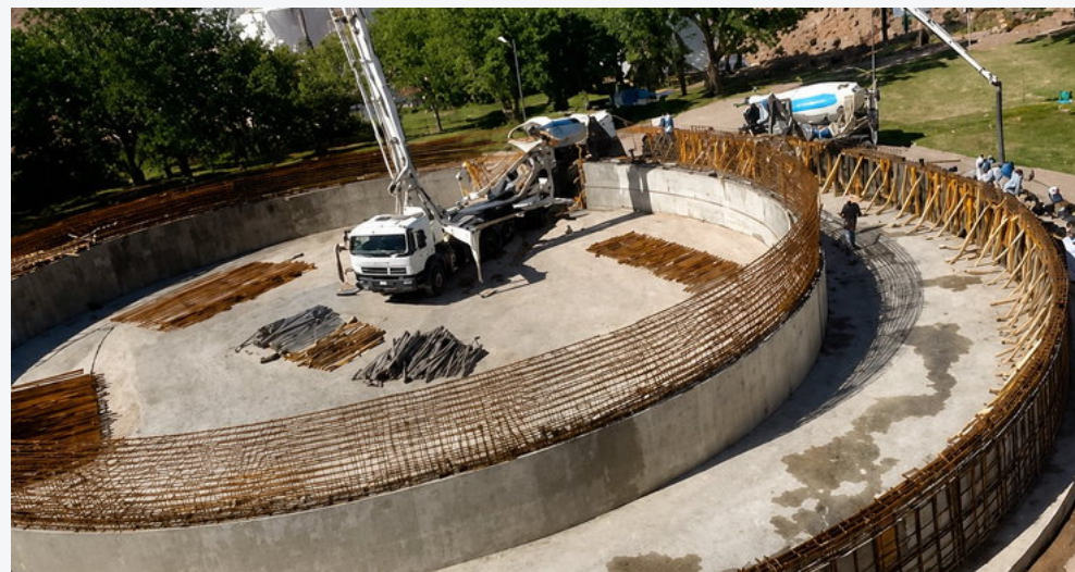
ESTRUCTURA DE OBRA CIVIL
