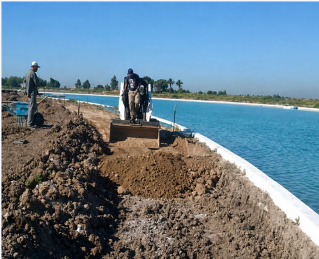
MOVIMIENTO DE SUELOS JUNTO A LA LAGUNA
